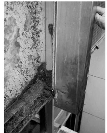
Figure 5: État d'une membrure horizontale à la suite de l'opération d'exploration
